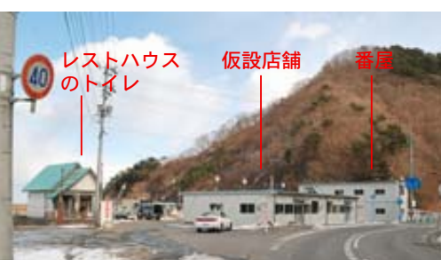
仮設店舗などが建設された太田名部レストハウス跡地
