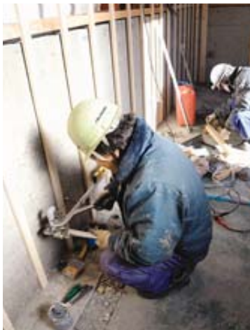
トイレの配管を組む北田尚さん
