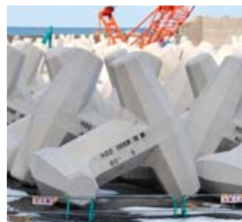
高さ6.1m、重さはなんと80ト
